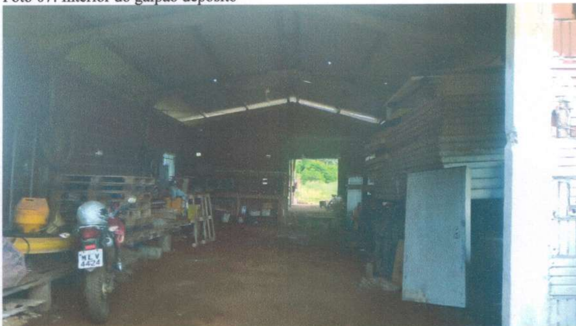
Foto 07: Interior do galpão depósito
