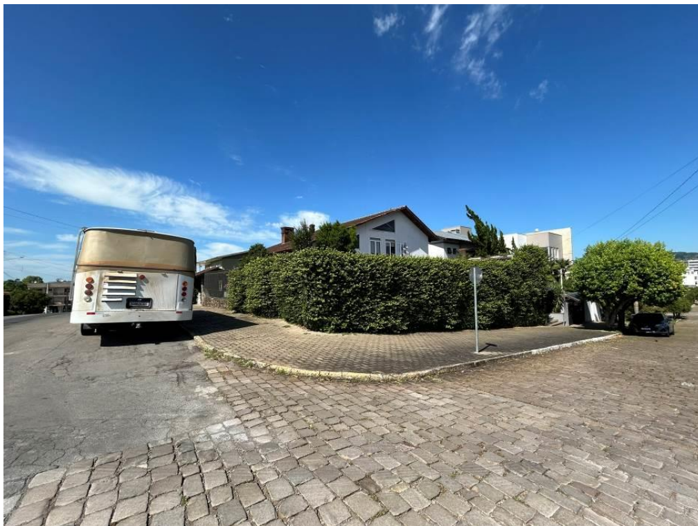
Vista do imóvel tomada a partir da esquina das ruas Airton Tomazetto e Rua Manoel Francisco Guerreiro.
